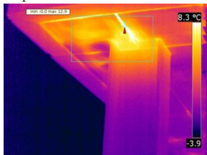
Obr. 7 Přechod nosného ocelového sloupu
